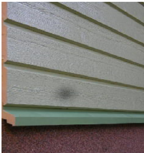
b.- puitfassaadi alaserv
